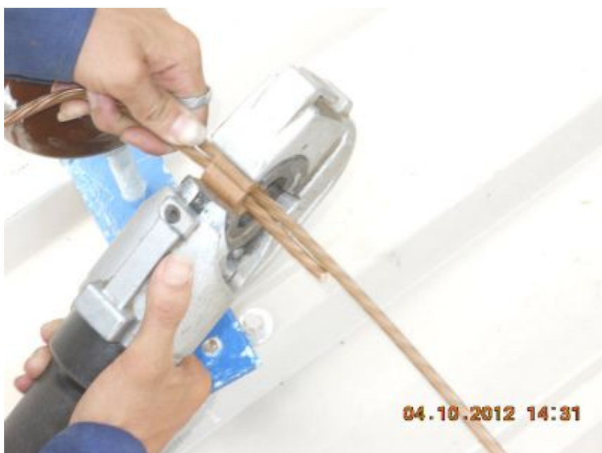
HÌNH ẢNH THI CÔNG LẮP ĐẶT KIM CHỐNG SÉT
