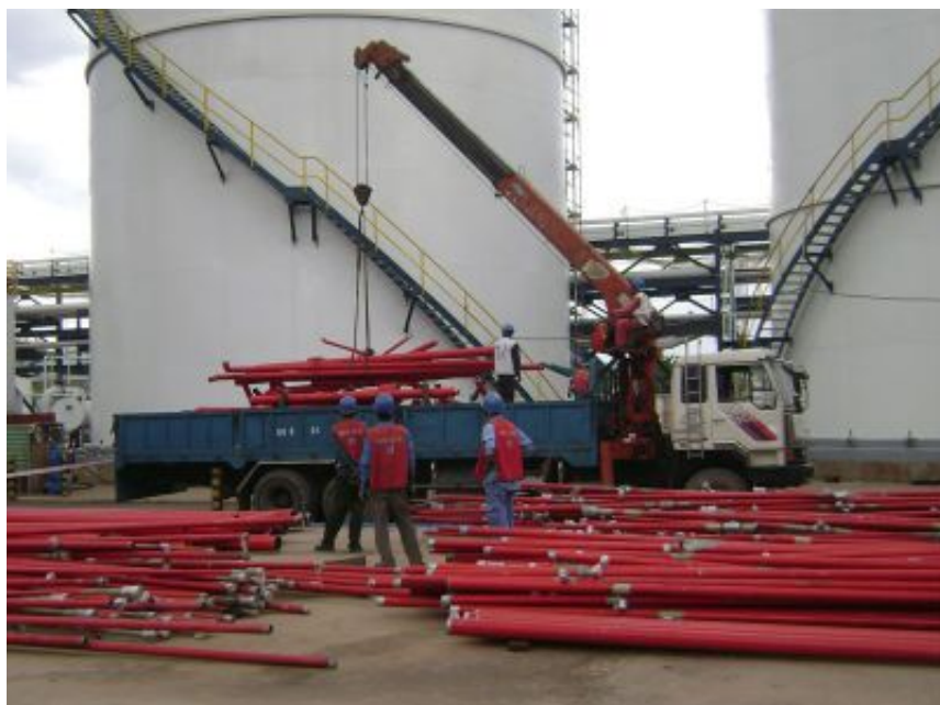
HÌNH ẢNH THI CÔNG LẮP ĐẶT ỐNG CẤP NƯỚC PCCC
