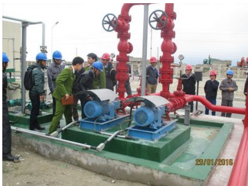
HÌNH ẢNH KIỂM TRA NGHIỆM THU PCCC
