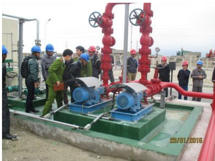
HÌNH ẢNH KIỂM TRA NGHIỆM THU PCCC
