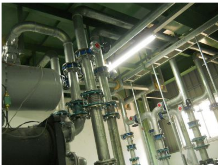
HÌNH ẢNH THI CÔNG LẮP ĐẶT MÁY LÀM LẠNH CHILER
