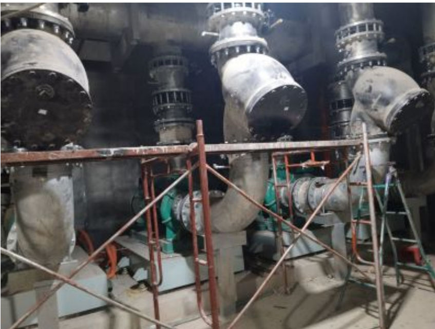
HÌNH ẢNH THI CÔNG LẮP ĐẶT TRẠM BƠM HỆ THỐNG LẠNH
