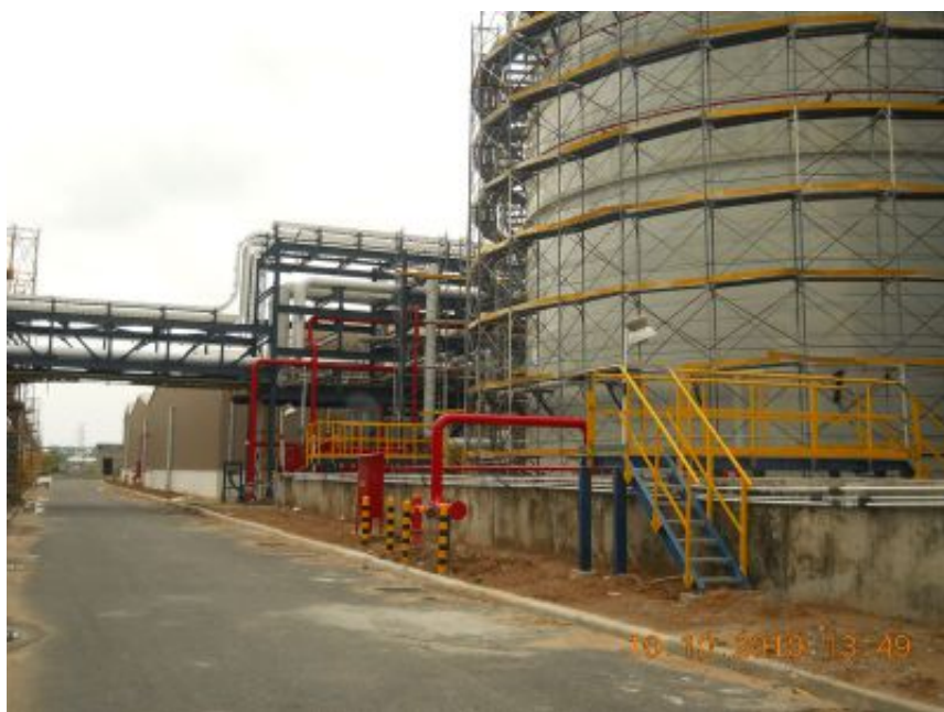
HÌNH ẢNH LẮP ĐẶT TRẠM BƠM CẤP NƯỚC PCCC
