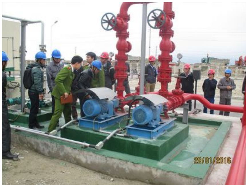
HÌNH ẢNH KIỂM TRA NGHIỆM THU PCCC
