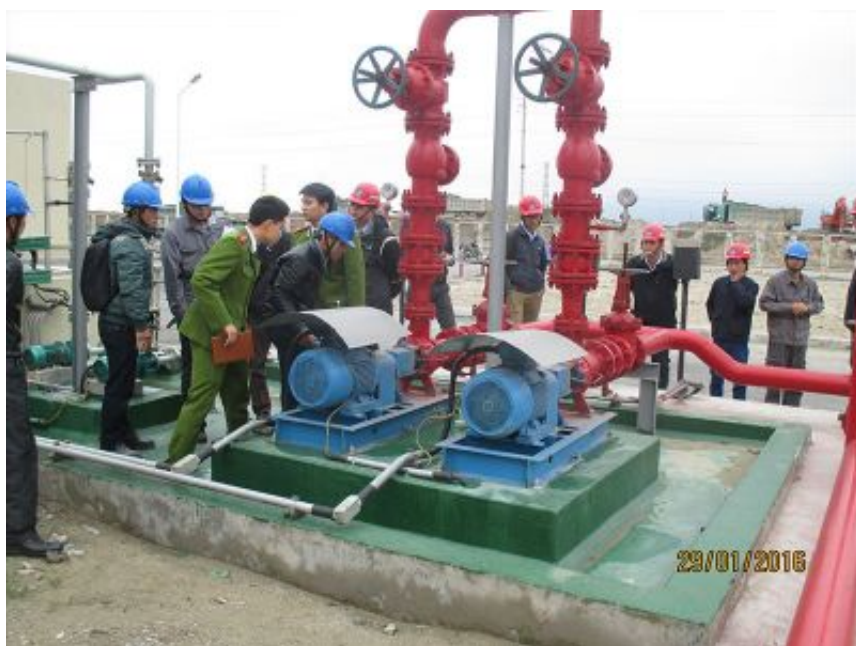
HÌNH ẢNH KIỂM TRA NGHIỆM THU PCCC
