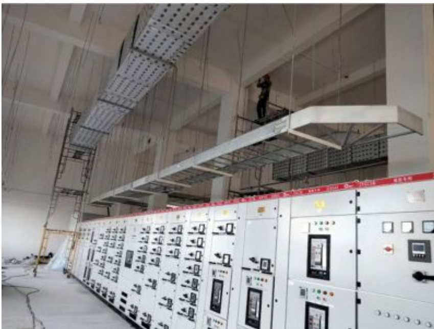
HÌNH ẢNH THI CÔNG LẮP ĐẶT TỦ TRUNG - HẠ THẾ
