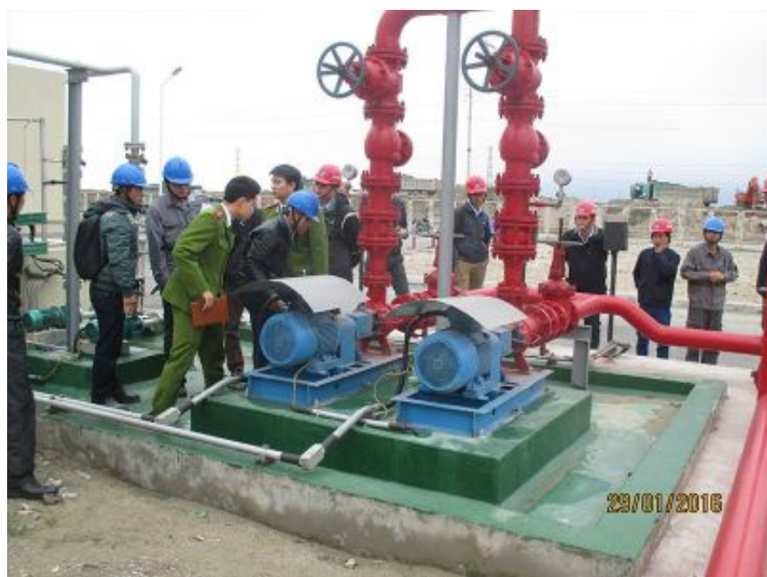
HÌNH ẢNH KIỂM TRA NGHIỆM THU PCCC
