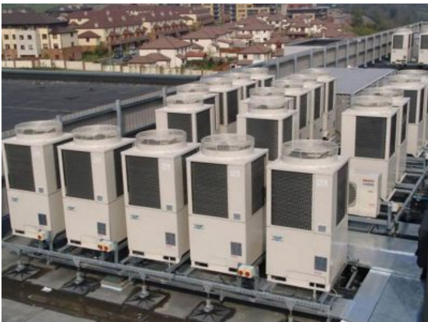
HÌNH ẢNH THI CÔNG LẮP ĐẶT HỆ THỐNG LẠNH TRUNG TÂM VRV
