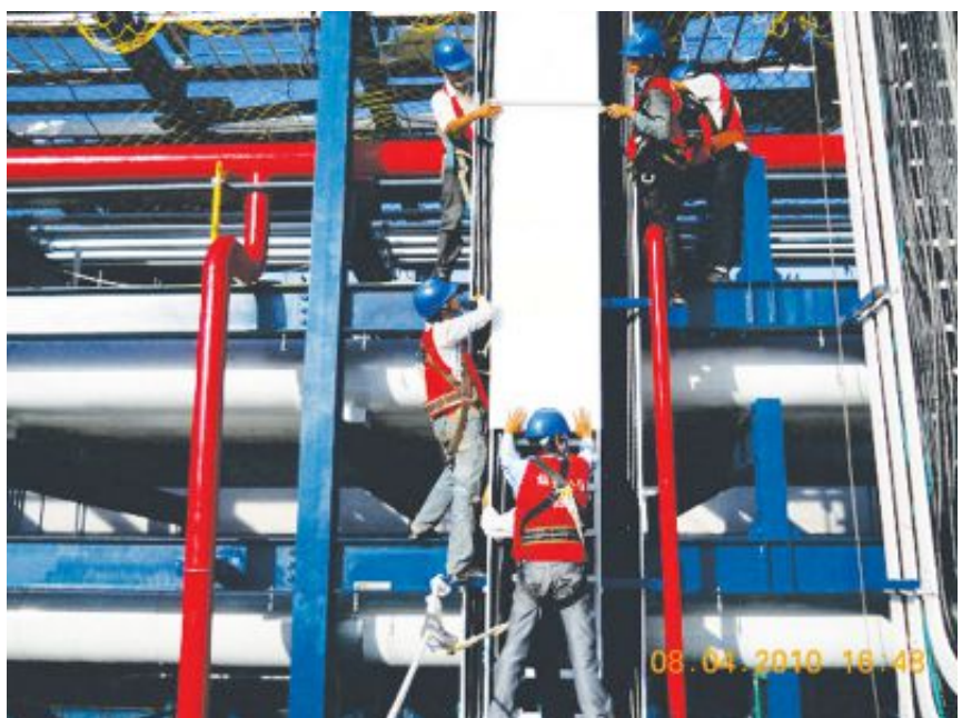
HÌNH ẢNH THI CÔNG LẮP ĐẶT MÁNG CÁP - KÉO CÁP ĐIỆN NHÀ MÁY
