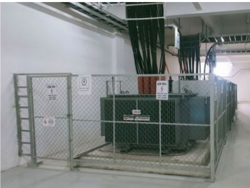
HÌNH ẢNH THI CÔNG LẮP ĐẶT TRẠM ĐIỆN TRUNG THẾ
