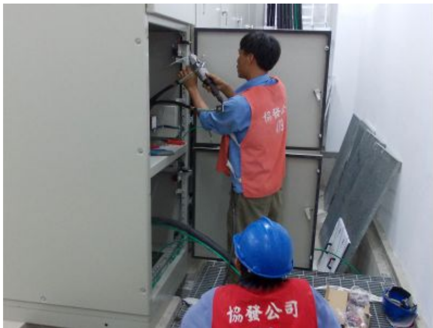
HÌNH ẢNH THI CÔNG ĐẦU NỐI CÁP TRUNG THỂ
