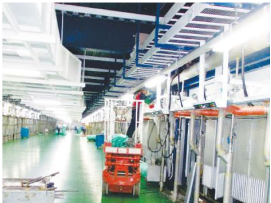
HÌNH ẢNH THI CÔNG LẮP ĐẶT HỆ THỐNG CHIẾU SÁNG NHÀ MÁY
